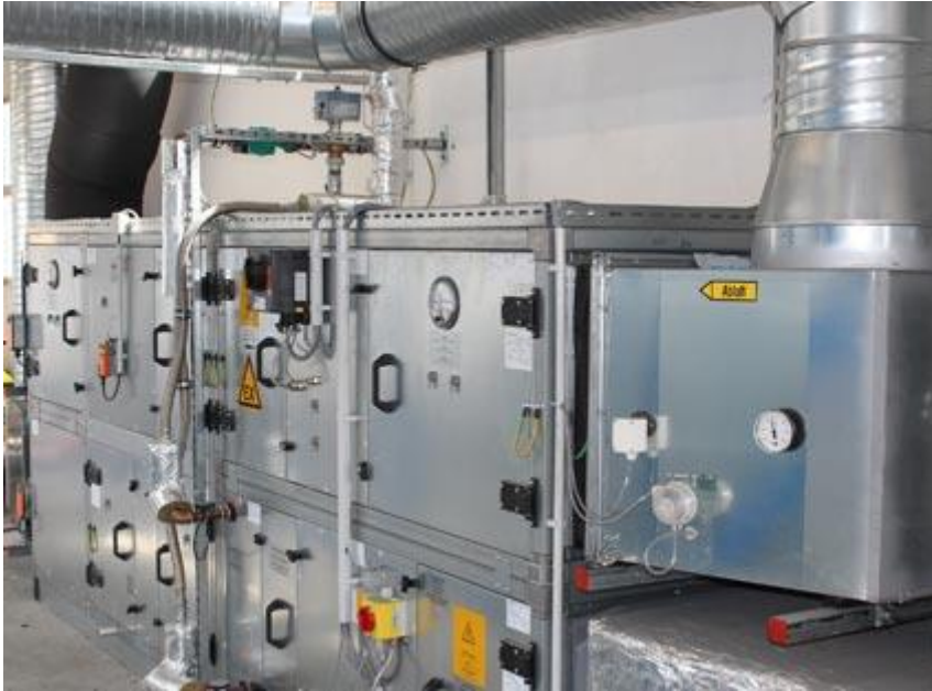
Bild 5: Schaltschrank mit Filtermodulen und Abluftrohren
