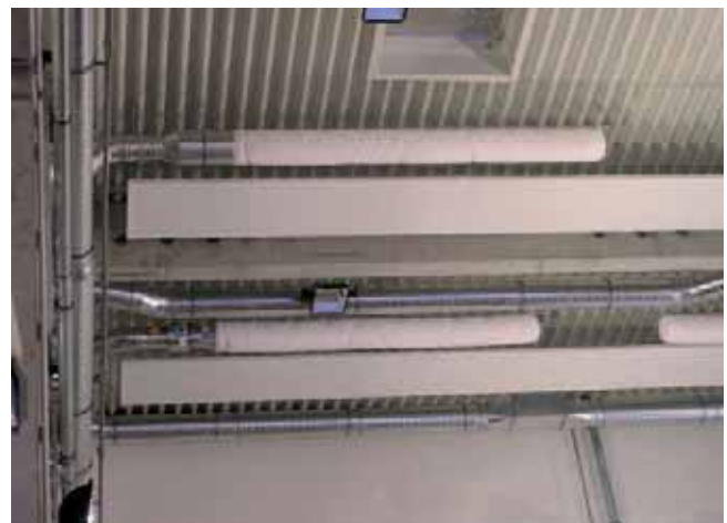
Bild 2. Luftzuführung unter der Decke
